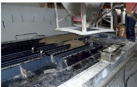
Figura 2 Gabbie metalliche delle travi sollecitate a taglio (immagine a sinistra).
